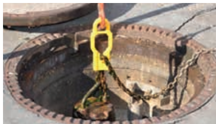
Heben von Pumpen mittels Pumpengreifstück
